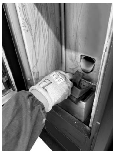
Fig. 27 - Verwijdering vuurpot
