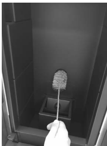
Fig. 30 - Reiniging met flessenwisser
