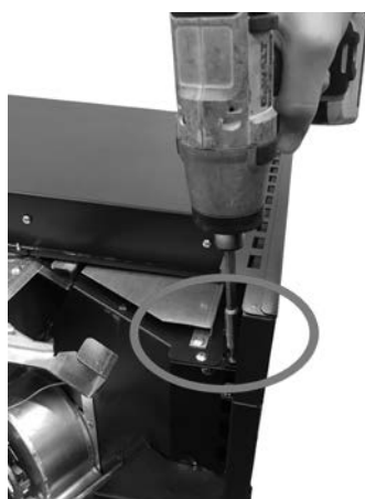
Fig. 54 - Fixação dianteira da gaveta
