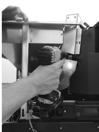
Fig. 44 - Fixe o ventilador
