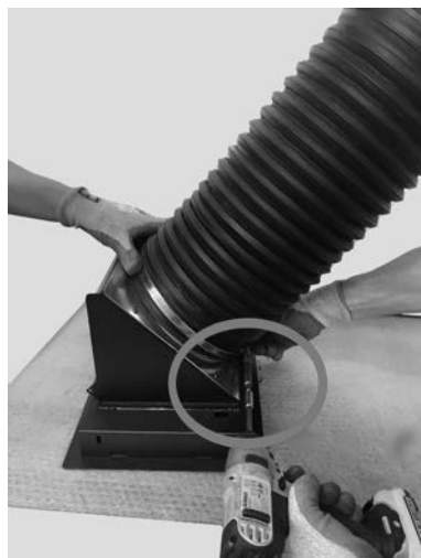
Fig. 62 - Apertar a abraçadeira
