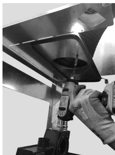
Fig. 65 - Fixação do tubo flexível
