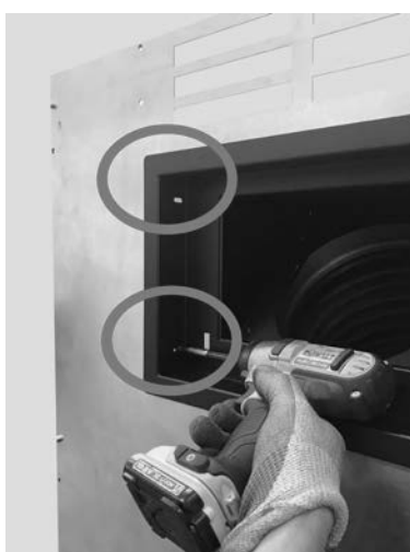
Fig. 66 - Fixação externa do alçapão
