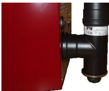
Fig. 39 - Reinigung des Rauchgaskanals
