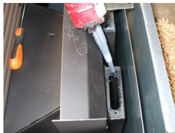
Fig. 46 - Silikon verlegen
