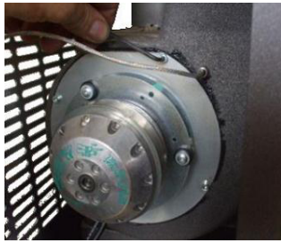
Fig. 40 - Reinigung Rauchgasansauggerät: Phase 1
