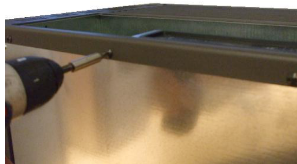
Fig. 16 - Rimozione viti sul retro
