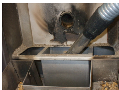
Fig. 27 - Pulizia vano braciere
