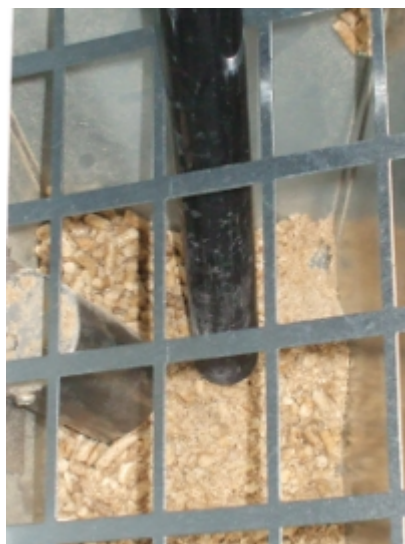
Fig. 29 - Nettoyage réservoir et vis sans fin
