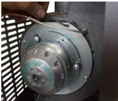
Fig. 33 - Nettoyage de l'aspirateur des fumées: phase 1
