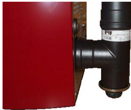
Fig. 32 - Pulizia canale da fumo
