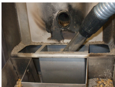
Fig. 27 - Nettoyage l'espace du brasero
