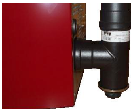
Fig. 32 - Nettoyage du conduit de fumée
