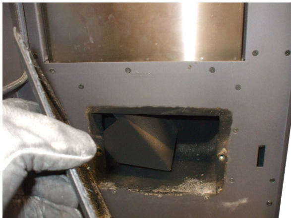
Fig. 30 - Chambre des fumées
