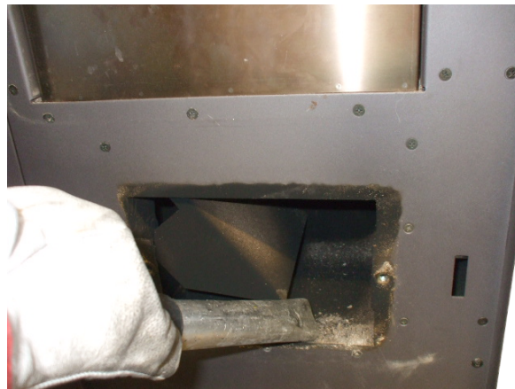
Fig. 31 - Nettoyage de la chambre des fumées
