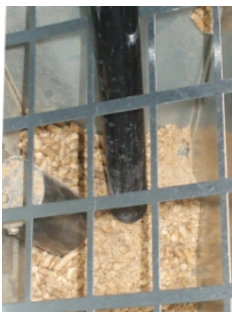
Fig. 26 - Nettoyage réservoir et vis sans fin
