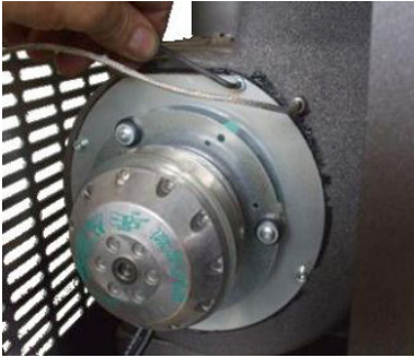
Fig. 31 - Pulizia aspiratore fumi: fase 1
