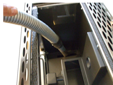
Fig. 22 - Pulizia camera di combustione
