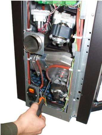
Fig. 84 - Fume fan cleaning: phase 1
