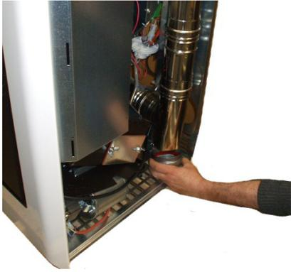
Fig. 82 - Fume conduit cleaning
