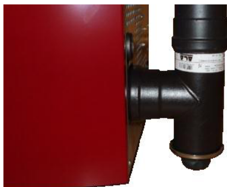
Fig. 34 - Limpieza canal de humos
