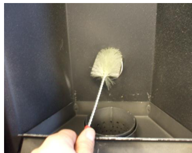
Fig. 29 - Limpieza con escobilla
