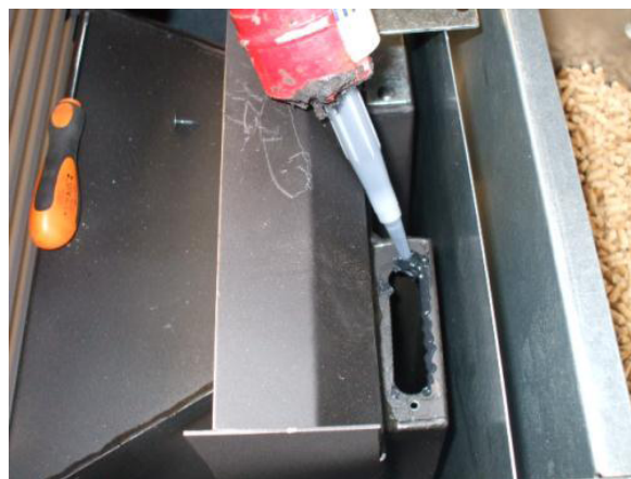
Fig. 41 - Colocação de silicone
