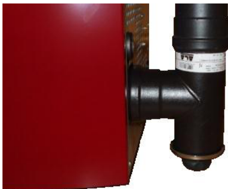
Fig. 34 - Limpeza do canal de fumo
