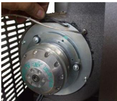
Fig. 35 - Limpieza del aspirador de humos: fase1
