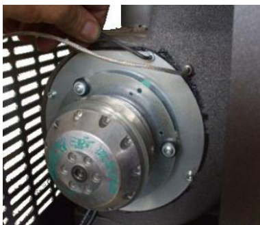
Fig. 35 - Limpeza do aspirador de fumos: fase 1
