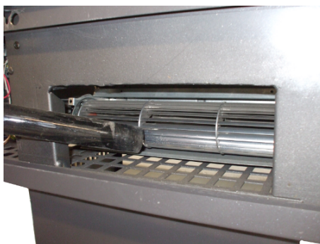
Fig. 40 - Room fan cleaning
