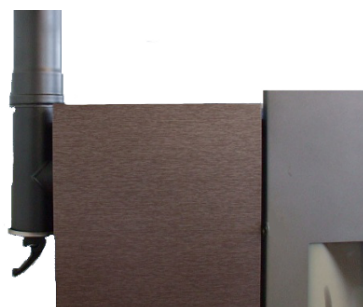
Fig. 36 - Fume conduit cleaning
