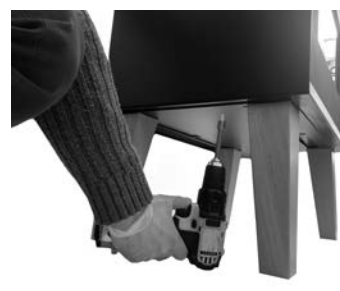
Fig. 21 - Mocowanie pieca
