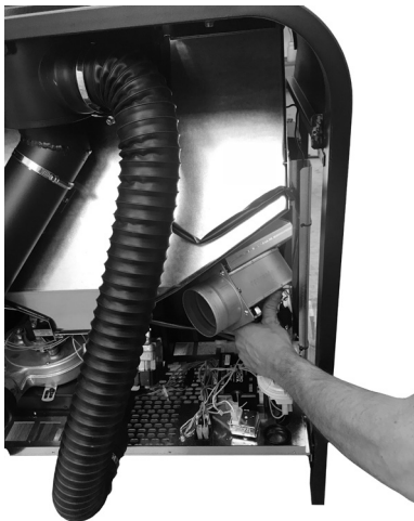
Fig. 37 - Bevestig de beschermkap + ventilator aan de kachel
