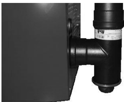
Fig. 64 - Reiniging rookleiding
