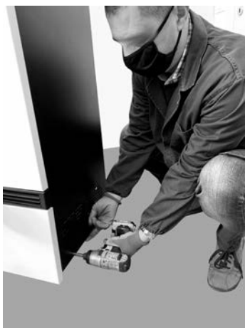
Fig. 44 - Remoção de parafusos
