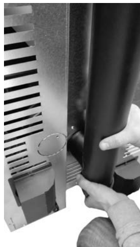
Fig. 54 - Conectar tubo d.80 mm
