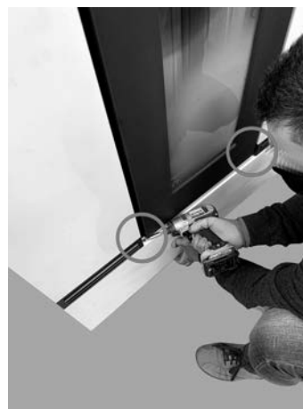
Fig. 43 - Fixar o painel inferior
