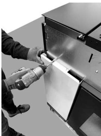
Fig. 40 - Fije los paneles laterales
