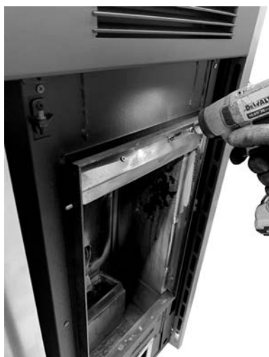
Fig. 100 - Retire el deflector
