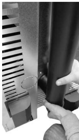
Fig. 59 - Acople el tubo d.80 mm
