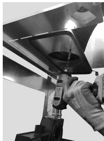
Fig. 72 - Fixation du tuyau flexible
