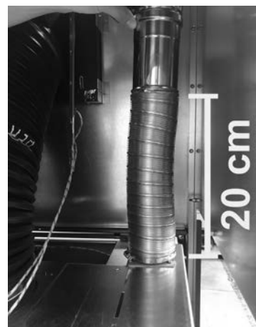
Fig. 55 - Raccordement du tube flexible (vue arrière de l'insert)
