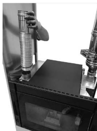
Fig. 67 - Insertion de l'insert
