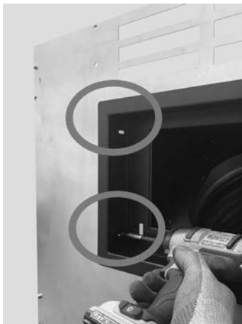
Fig. 73 - Fixation externe de la trappe
