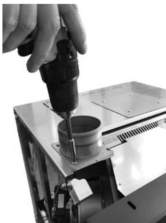
Fig. 54 - Fixer le raccord
