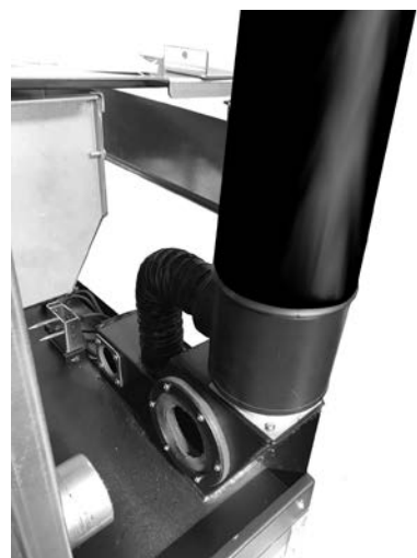
Fig. 84 - Raccordement d'un conduit d'évacuation des fumées
