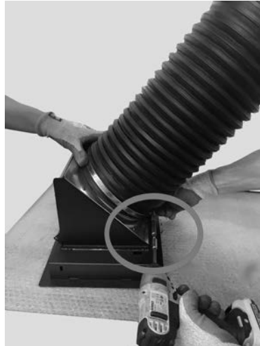
Fig. 62 - Schellen festziehen
