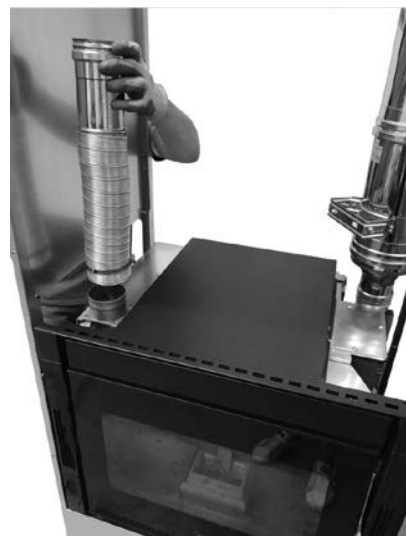
Fig. 60 - Einsetzen des Einsatzes
