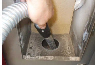
Fig. 40 - Reinigung Fach Brennschale
