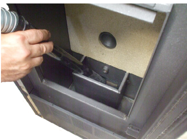
Fig. 43 - Reinigung Fach Brennschale
