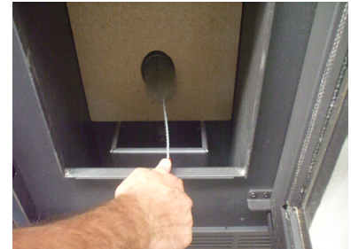
Fig. 45 - Reinigung mit Flaschenbürste
