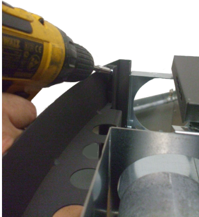
Fig. 15 - Entfernen der oberen gebogenen Profile
