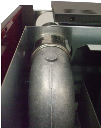
Fig. 33 - Positionierung der hinteren Rohre
