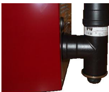
Fig. 42 - Rengøring af røgkanal
