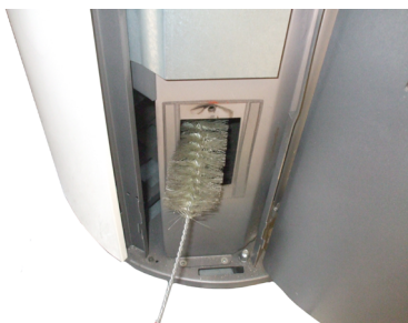
Fig. 61 - Rengøring med børste kanaler
