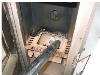
Fig. 36 - Rengøring af fyrfadsrum
