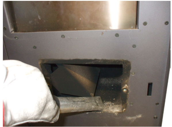
Fig. 31 - Καθαρισμό αγωγού καυσαερίων
