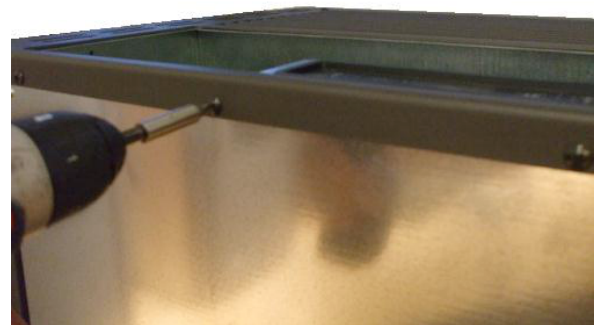
Fig. 16 - Αφαίρεση πίσω βιδών
