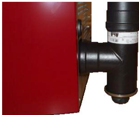
Fig. 32 - Καθαρισμός αγωγού καυσαερίων
