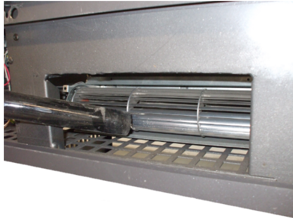
Fig. 36 - Καθαρισμός ανεμιστήρα δωματίου
