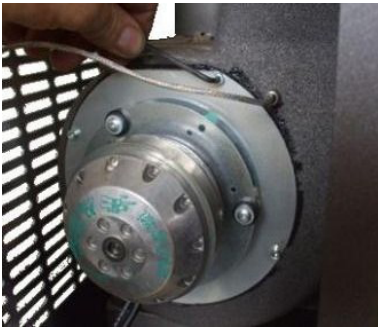
Fig. 33 - Καθαρισμό ανεμιστήρα καυσαερίων : Φάση 1
