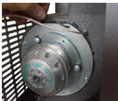
Fig. 32 - Reiniging rookgassenafzuiger: fase 1
