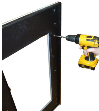
Fig. 34 - Die Steinelemente befestigen
