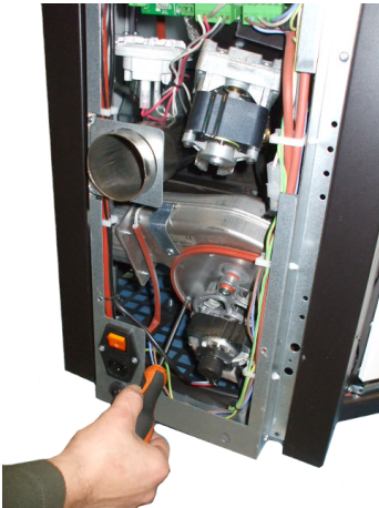
Fig. 84 - Reinigung Rauchgasansauggerät: Phase 1
