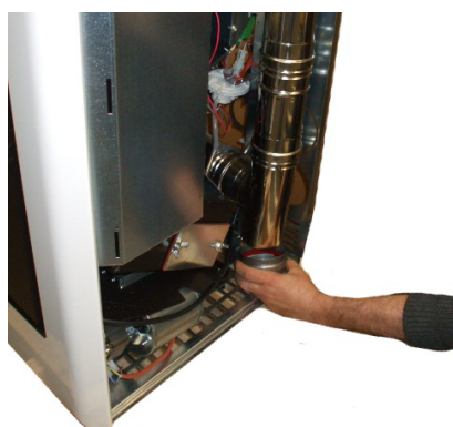
Fig. 82 - Reinigung des Rauchgaskanals
