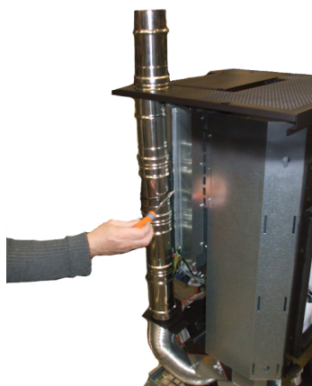
Fig. 45 - Positionierung der Rohre für oberen Kanal
