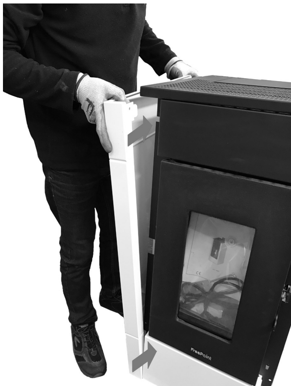
Fig. 30 - Sujete los laterales
