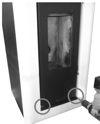
Fig. 25 - Befestigen des Rahmens
