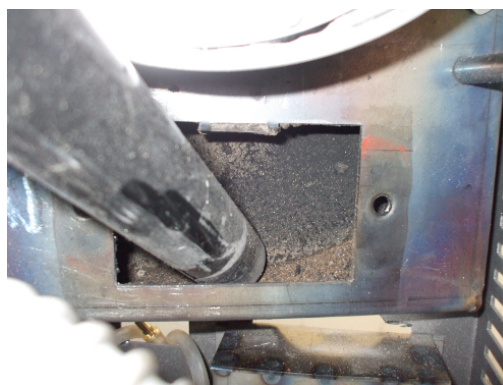
Fig. 35 - Čiščenje dimne komore
