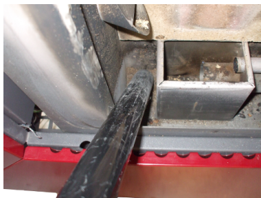
Fig. 31 - Čiščenje prostora za predal s pepelom
