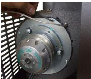
Fig. 37 - Čiščenje aspiratorja dimnih plinov: faza 1
