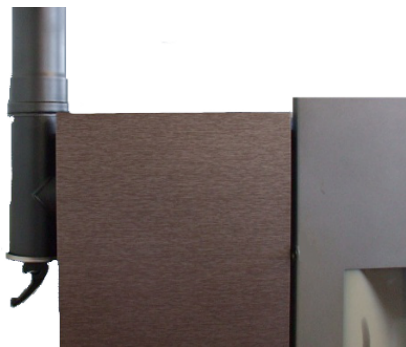
Fig. 36 - Čiščenje dimnega kanala
