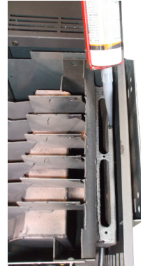
Fig. 44 - Colocação de silicone
