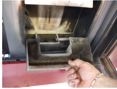
Fig. 28 - Remoção da gaveta de cinzas
