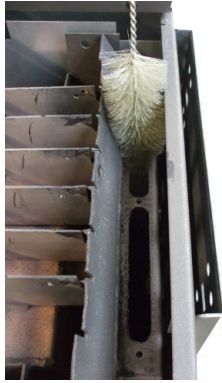
Fig. 43 - Limpeza canais
