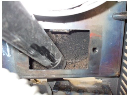
Fig. 35 - Limpeza da câmara de fumos
