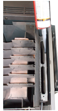
Fig. 44 - Aanbrengen siliconenkit
