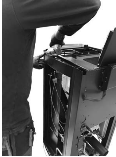
Fig. 53 - Kompansatörün çıkartılması
