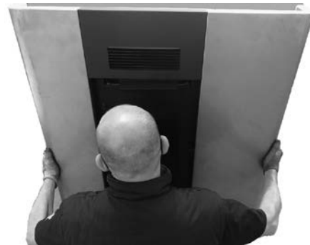
Fig. 47 - Çerçevenin yerleştirilmesi
