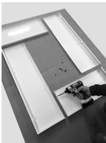
Fig. 23 - Fixação dos painéis 1
