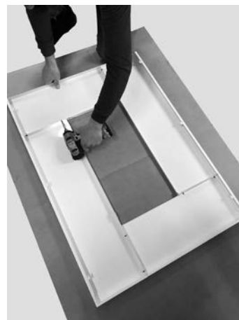
Fig. 24 - Fixação dos painéis 2
