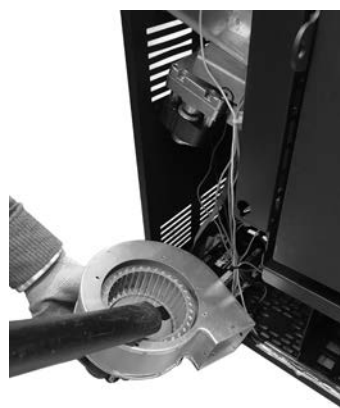
Fig. 71 - Limpeza do ventilador ambiente
