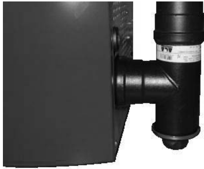
Fig. 63 - Reiniging rookleiding
