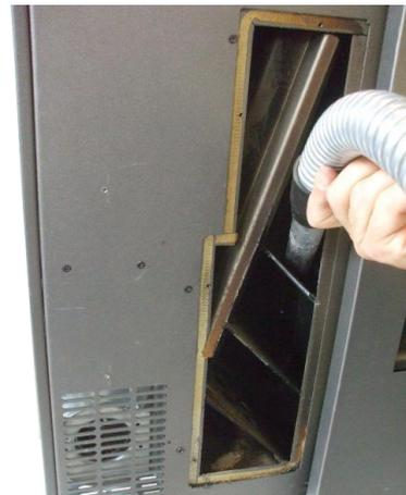
Fig. 44 - Reinigung Rauchgaskammer
