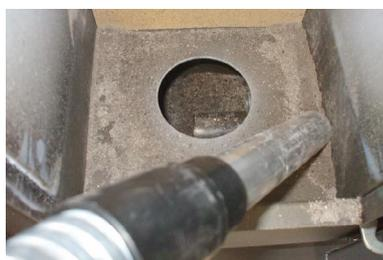
Fig. 37 - Reinigung Fach Aschenkasten
