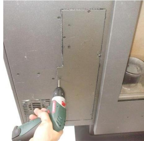
Fig. 42 - Die Inspektionsplatte entfernen
