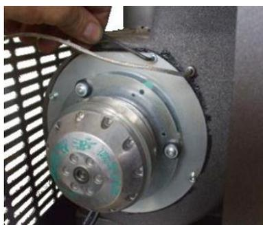
Fig. 46 - Reinigung Rauchgasansauggerät: Phase 1
