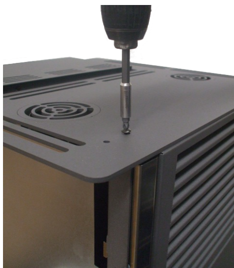
Fig. 19 - Verwijdering bovenste schroeven
