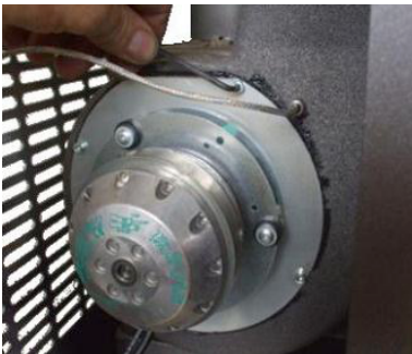
Fig. 50 - Reiniging rookgassenafzuiger: fase 1
