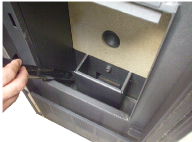
Fig. 44 - Reiniging ruimte aslade
