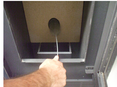
Fig. 45 - Reiniging met flessenwisser
