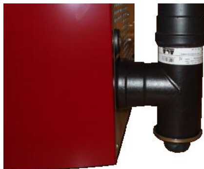
Fig. 49 - Reiniging rookleiding
