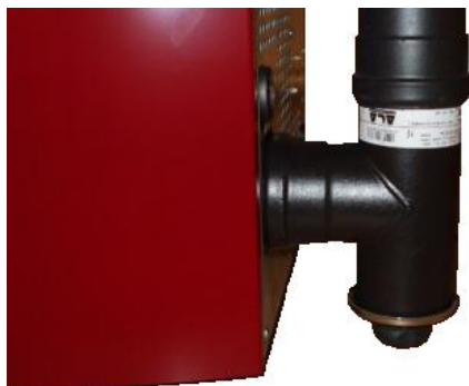
Fig. 49 - Fume conduit cleaning
