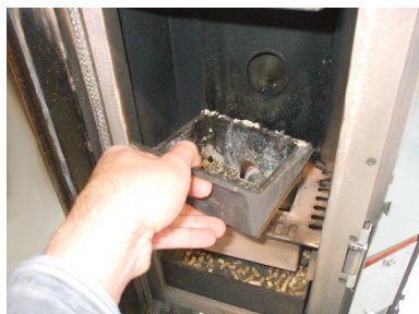
Fig. 33 - Brennschale entnehmen
