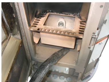
Fig. 37 - Reinigung Fach Aschenkasten
