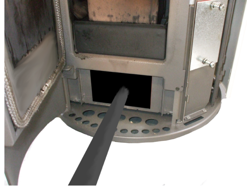
Fig. 41 - Reinigung Rauchgaskammer
