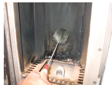
Fig. 38 - Reinigung mit Flaschenbürste
