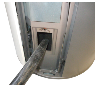
Fig. 62 - Reinigung Kanäle
