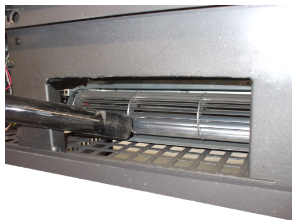
Fig. 47 - Reinigung Raumventilator
