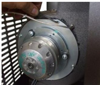
Fig. 43 - Reinigung Rauchgasansauggerät: Phase 1
