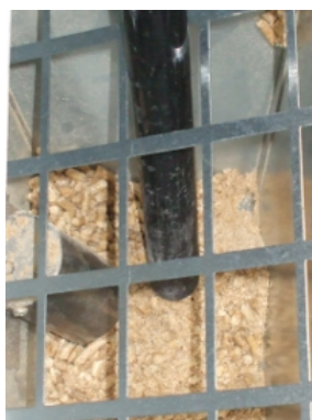
Fig. 39 - Reinigung Tank und Schnecke
