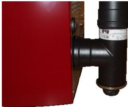
Fig. 42 - Reinigung des Rauchgaskanals
