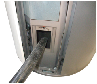
Fig. 62 - Reiniging kanalen
