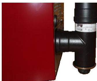
Fig. 42 - Reiniging rookleiding
