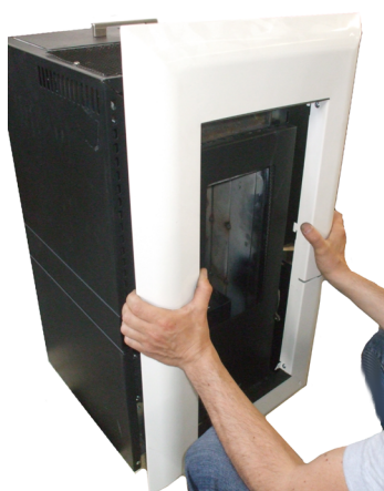
Fig. 21 - Montage frontpaneel
