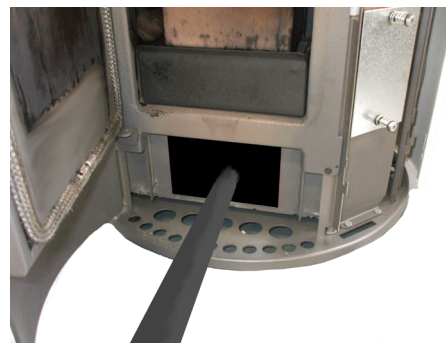
Fig. 41 - Reiniging rookgassenkamer
