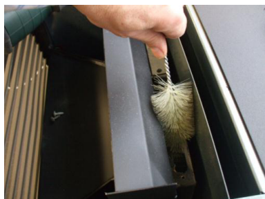
Fig. 45 - Nettoyage du canal
