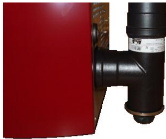
Fig. 39 - Nettoyage du collecteur des fumées
