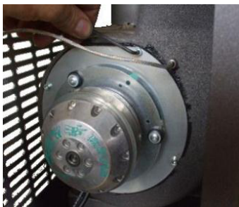
Fig. 40 - Nettoyage de l'aspirateur des fumées: phase 1
