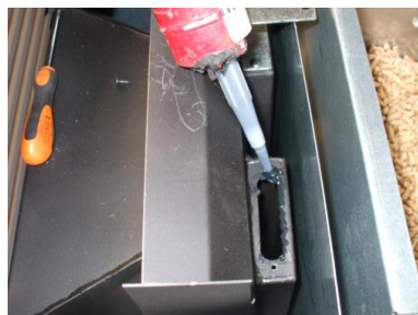
Fig. 46 - Application de la silicon
