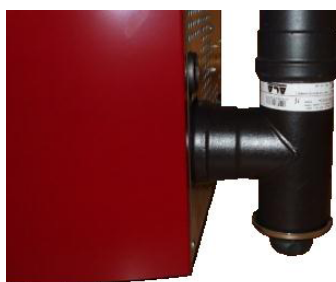
Fig. 39 - Pulizia canale da fumo
