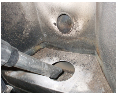
Fig. 33 - Nettoyage brasero
