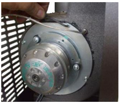
Fig. 31 - Fume fan cleaning: phase 1
