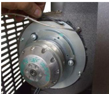
Fig. 32 - Nettoyage de l'aspirateur des fumées: phase 1
