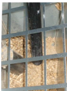
Fig. 27 - Nettoyage réservoir et vis sans fin
