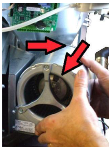
Fig. 62 - De ventilator verwijderen
