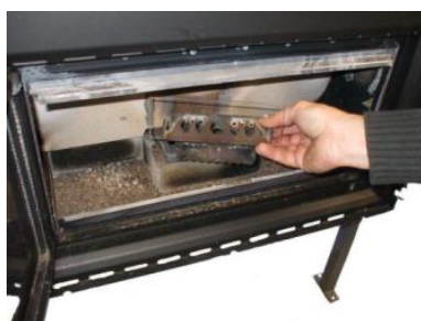
Fig. 39 - Verwijdering vuurpot
