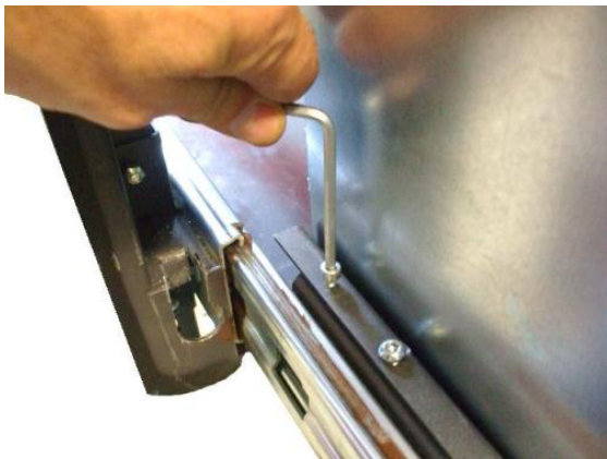
Fig. 20 - Schroef achteraan om het inbouwelement te bevestigen
