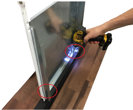
Fig. 36 - Rimozione frontalino
