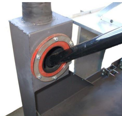
Fig. 49 - Pulizia canale da fumo
