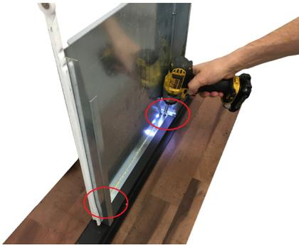
Fig. 37 - Extracción del frente
