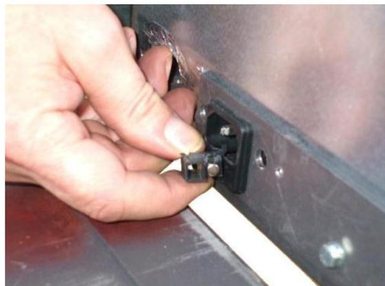
*Fig. 65 - Sustitución del fusible*
