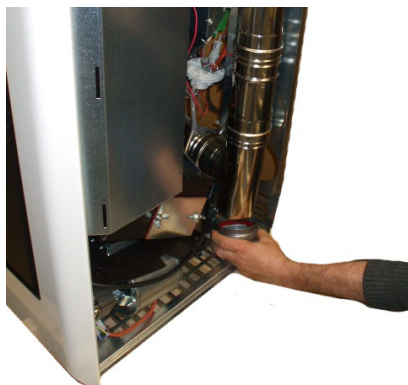
Fig. 82 - Καθαρισμός αγωγού καυσαερίων
