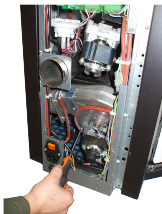
Fig. 84 - Καθαρισμό ανεμιστήρα καυσαερίων : Φάση 1
