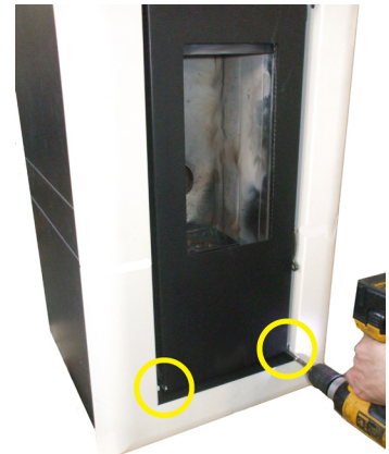
Fig. 24 - Στερέωση Μπροστινού Πάνελ
