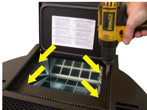
Fig. 69 - Extracción de los tornillos de la tapa 2
