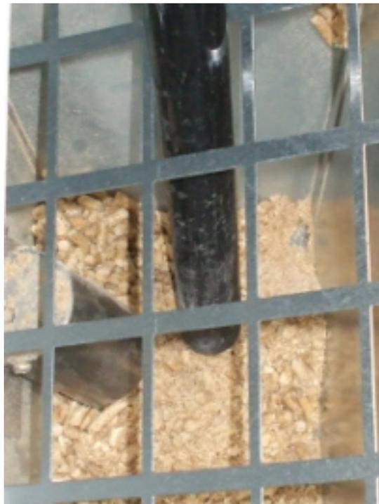
Fig. 61 - Limpieza depósito y coclea
