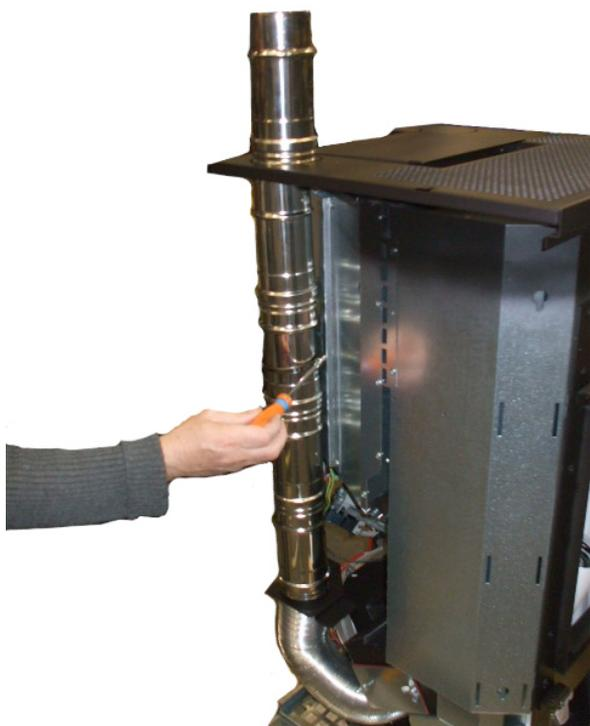
Fig. 46 - Posicionamiento superior de los tubos
