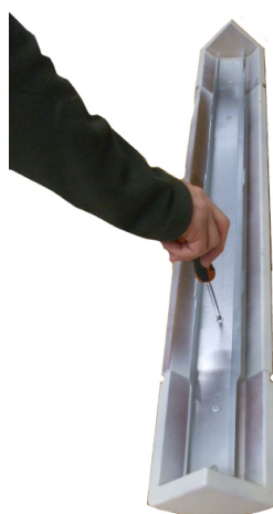
Fig. 26 - Schroef het profiel aan op de majolica's
