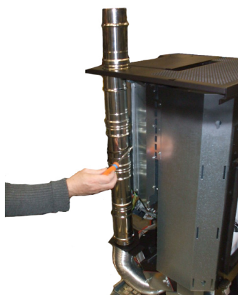
Fig. 45 - Positionering van de buizen voor kanalisering bovenaan
