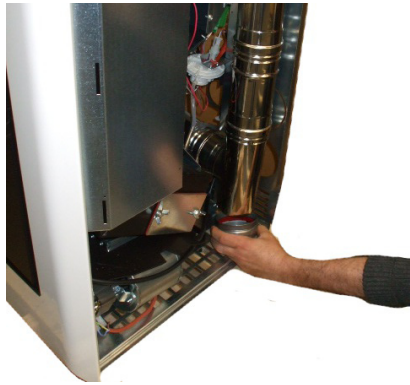
Fig. 82 - Reiniging rookleiding
