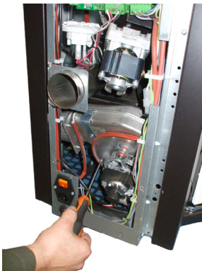
Fig. 84 - Reiniging rookgassenafzuiger: fase 1
