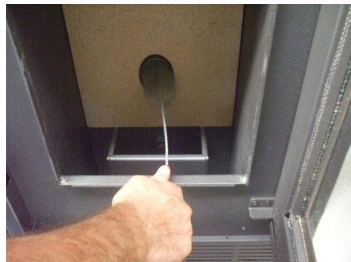
Fig. 59 - Reiniging met flessenwisser
