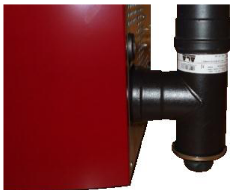
Fig. 34 - Reiniging rookleiding
