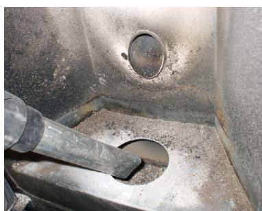
Fig. 28 - Reiniging ruimte vuurpot
