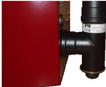
Fig. 34 - Fume conduit cleaning
