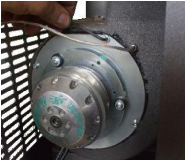
Fig. 35 - Fume fan cleaning: phase 1
