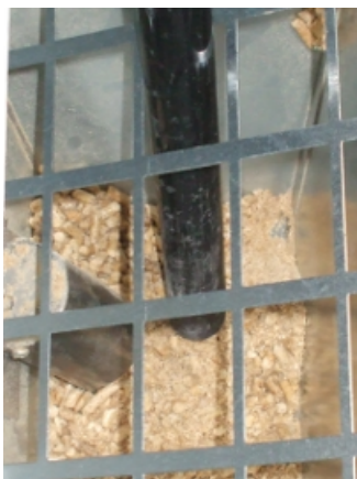
Fig. 31 - Reiniging van de voorraadbak en transportschroef
