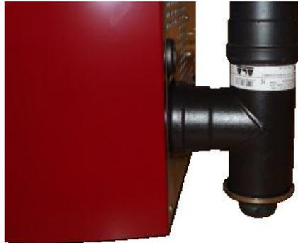
Fig. 94 - Nettoyage du conduit de fumée
