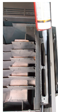
Fig. 44 - Silikon verlegen
