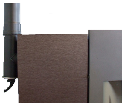
Fig. 36 - Reinigung des Rauchgaskanals
